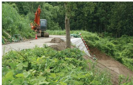
舗装道路終わり「のげま」部分の災害復旧工事を現在進行中です。この先「むじなざわ」の道路破断ヶ所等大がかりな工事となります。
